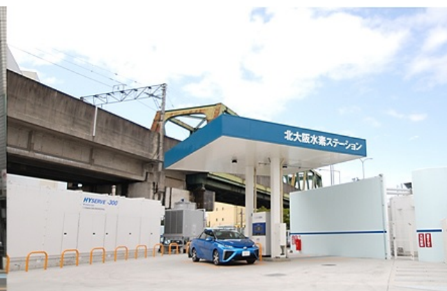
【北大阪水素ステーション】
