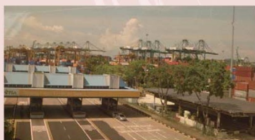
(コンテナヤードに入るためのゲート)
