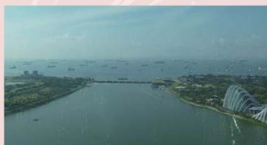
(シンガポール・フライヤーからダム全体をみた風景)
